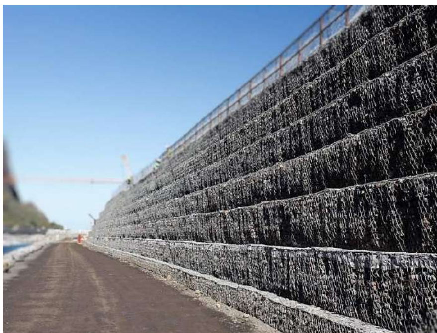
Illustration 33 : Gabions utilisés le long de la route littorale (Source : Maccaferri).
