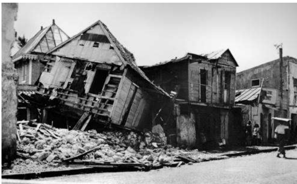
Illustration 22 : Boulevard Lancastel à Saint-Denis (Source : firinga.com).
