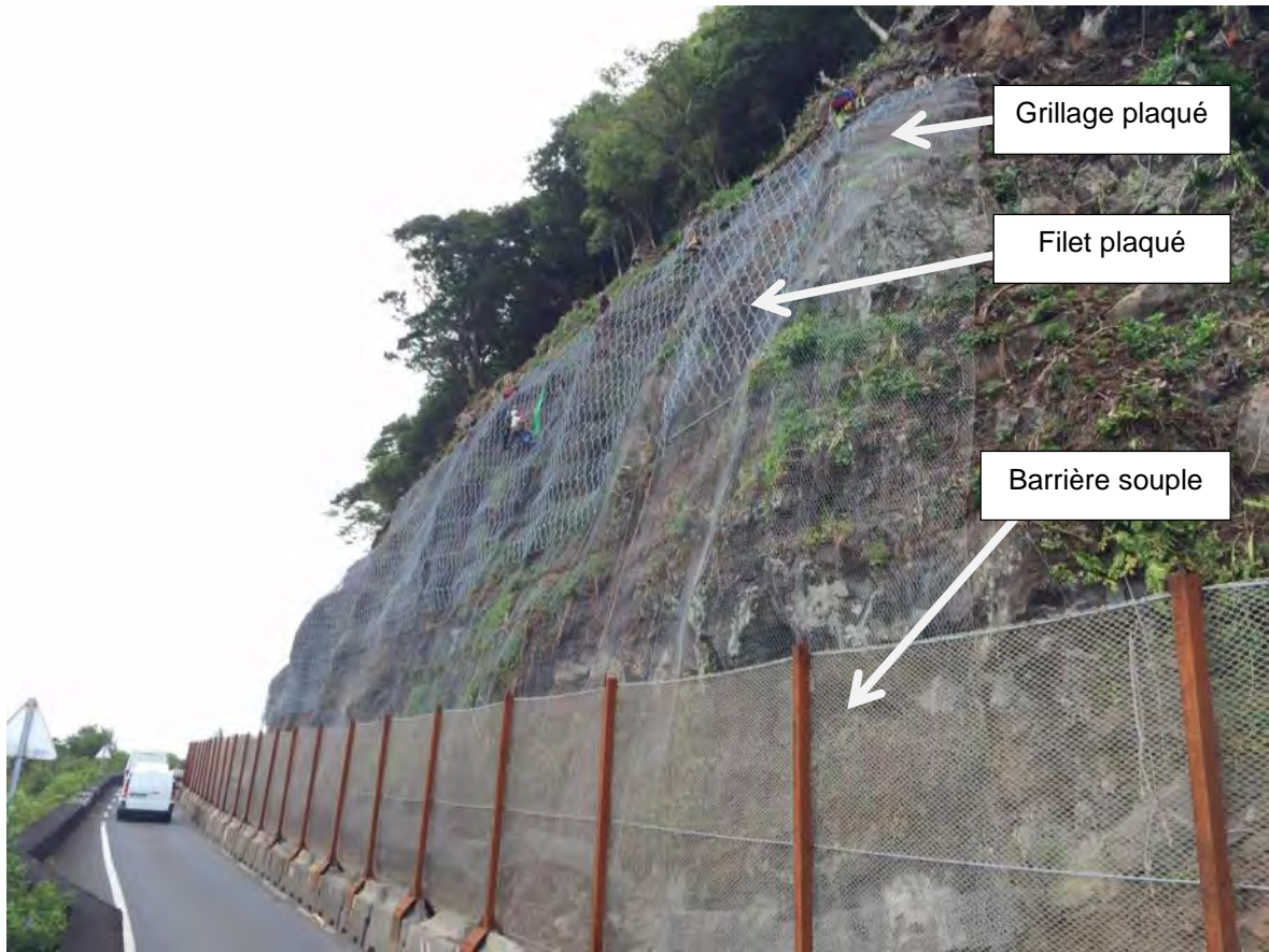
Photo.-1. Vue de la falaise sur secteur A à l'issue du chantier en novembre 2016
