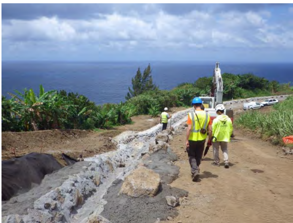
Photo.-3. Fossé hydraulique en crête de falaise, sur terrains agricoles
