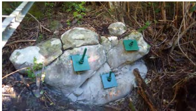
Ancrages de confortement de blocs
