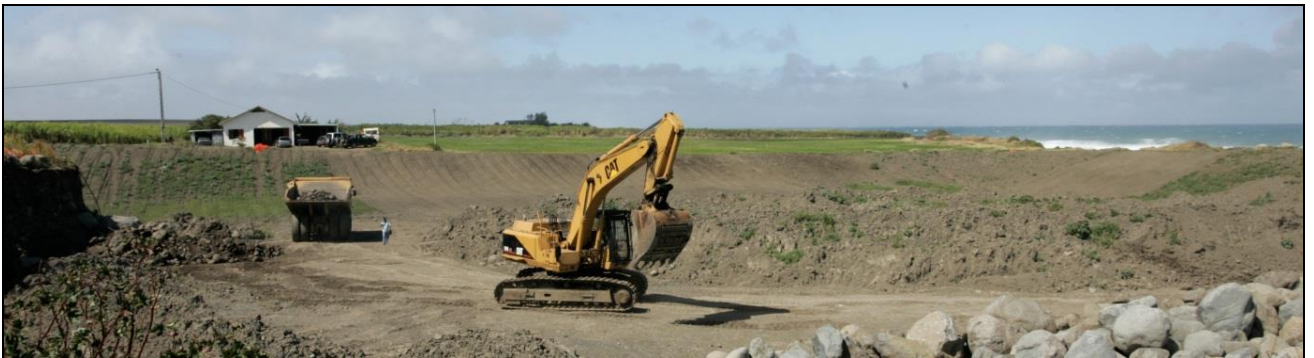
Remise en état et talutage
