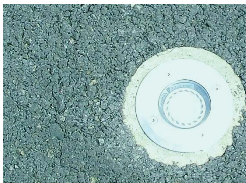
Figure 14 : Dispositif d'éclairage encastré au sol.
