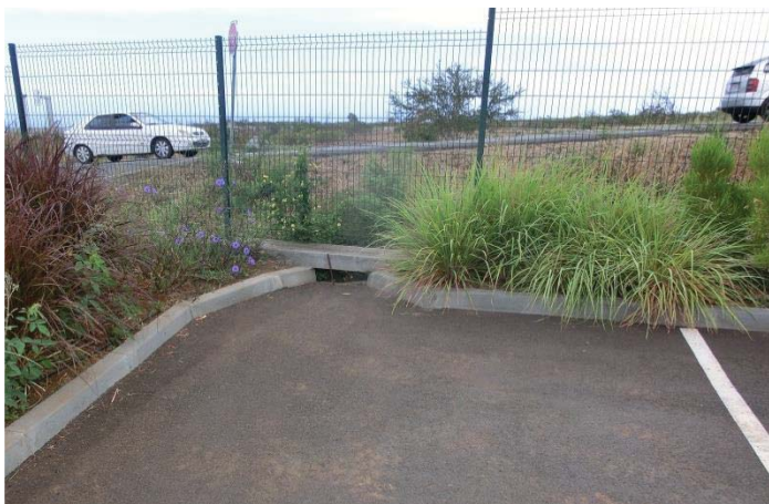
Figure 16 : Photo de l'exutoire des eaux pluviales.
