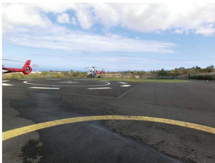
Figure 11 : Vue générale FATO et aires de stationnement.
