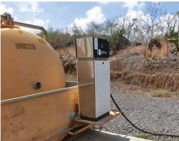
Figure 8 : Vue de la pompe de distribution.
