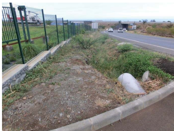
Figure 15 : Fossé collecteurs des eaux pluviales.
