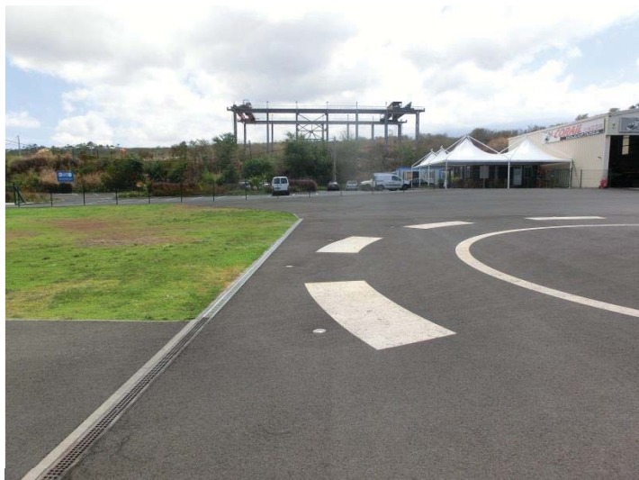
Figure 10: Vue du FATO et des bureaux et hangar, au second plan.
