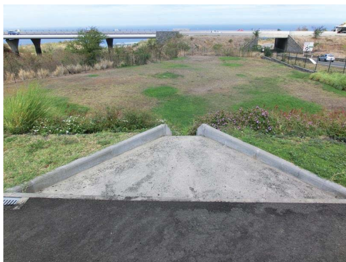
Figure 13 : Exutoire des caniveaux et vue sur aire de stationnement n°3.
