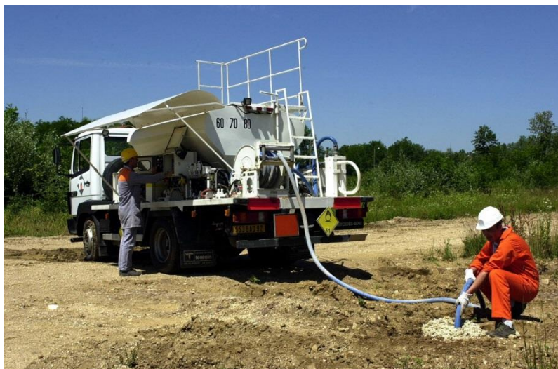
Planche 9 : Mise en œuvre d'explosif par une UMFE
