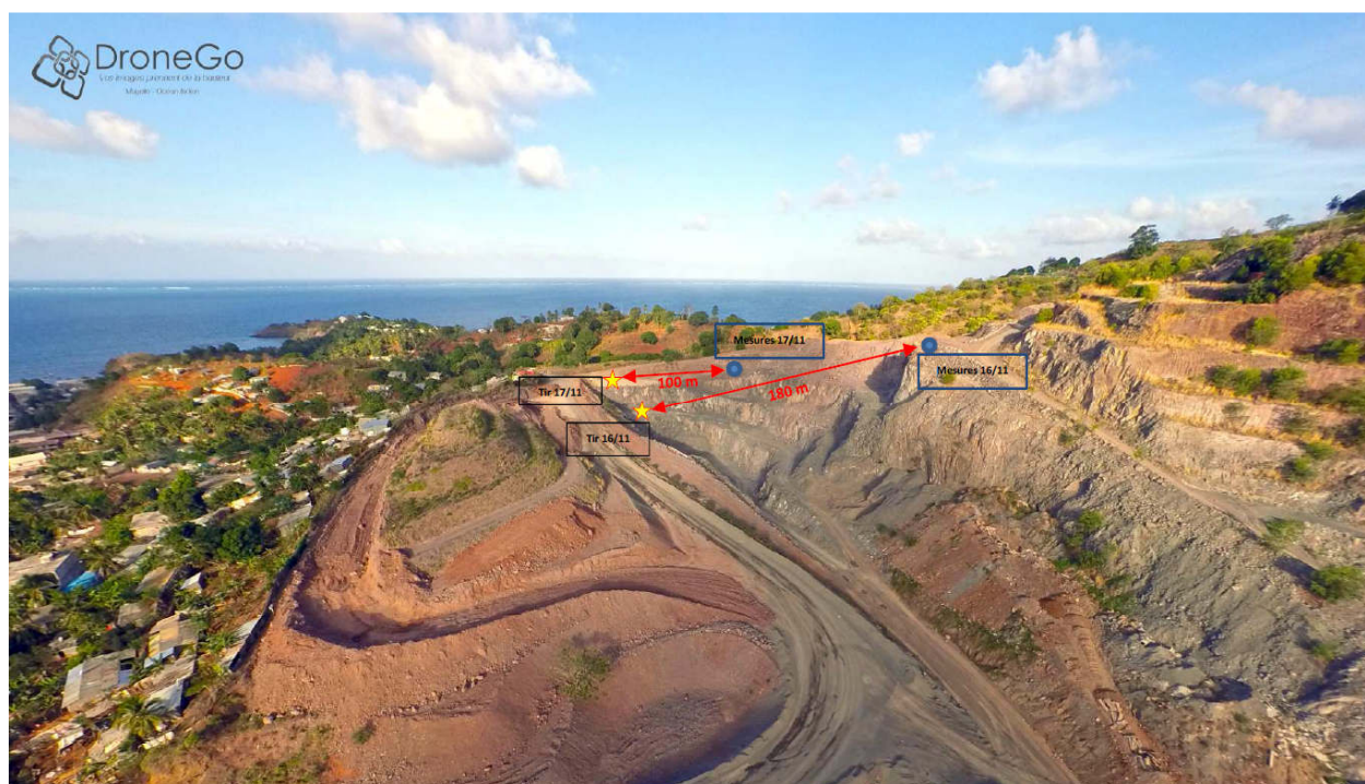
Figure 1 : configuration de la carrière de Koungou et emplacements de chaque tir de minage. Emplacements de sismographe (source ETPC)
