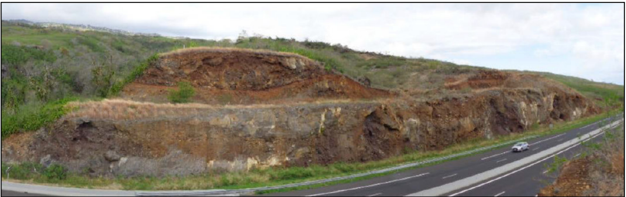
Figure 1 : Coulées et brèches observées sur le talus amont de la RN1, à proximité de la Ravine du Trou (extrait DDAE initial)
