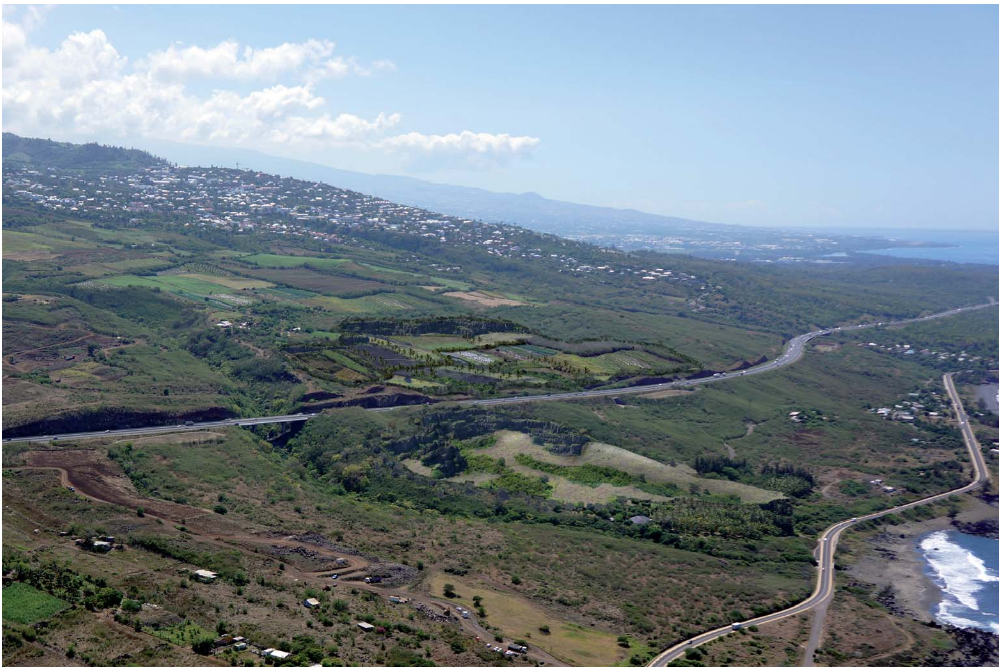
Planche 14 : L'ensemble du site réhabilité, avec l'intégration des deux sites de carrières dans le paysage environnant
