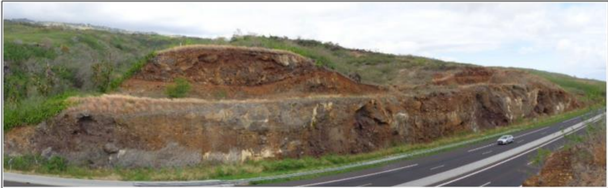
Vue des formations en présence dans les talus de la route des tamarins
