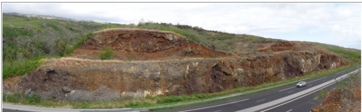
Photo 5 : coulées + brèches basaltiques - talus amont de la RN1 proche du pont de la ravine du Trou (prise de vue effectuée à une trentaine de mètre en amont du début du profil P16)
