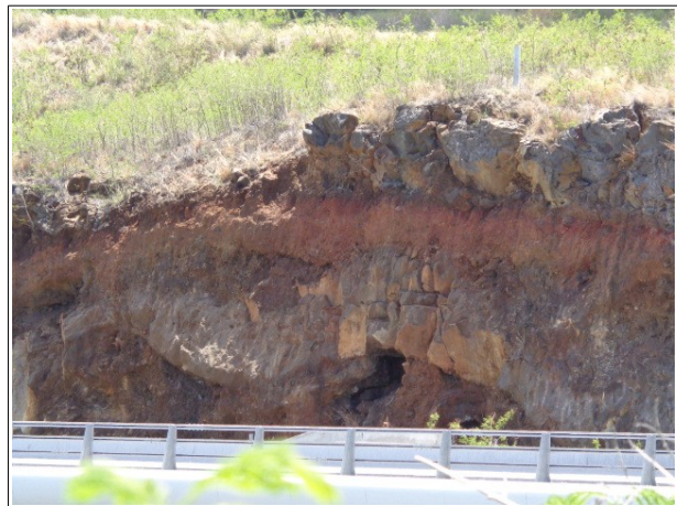
Photo 9 : coulées + brèches scoriacées (talus en amont du pont de la ravine du Trou)
