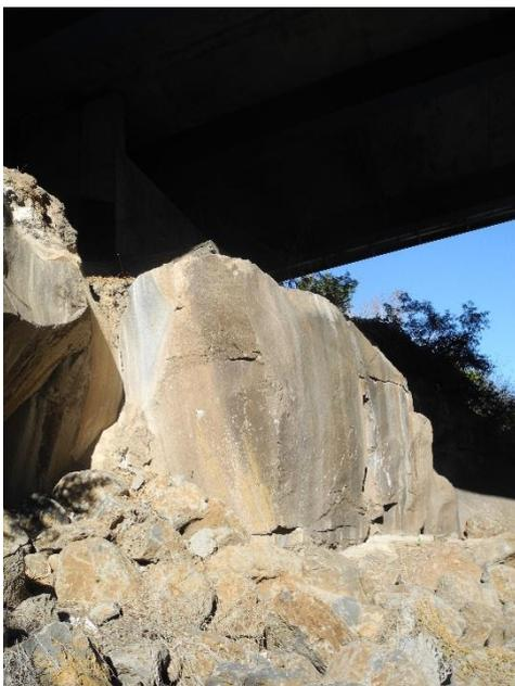
**Photographie 9 : Coulée de roche pintade sous l'appui rive gauche du pont de la ravine du Trou**
