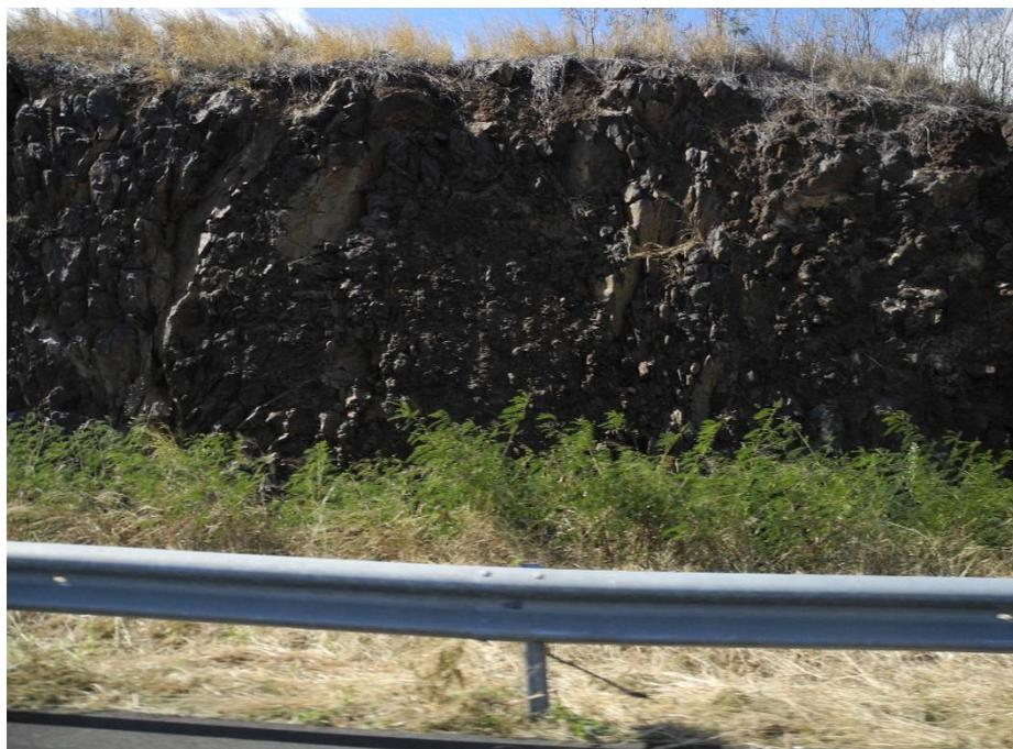
**Photographie 13 : Coulé de basalte bleu très fissurée, à débit décimétrique dans le talus amont de la route des Tamarins**
