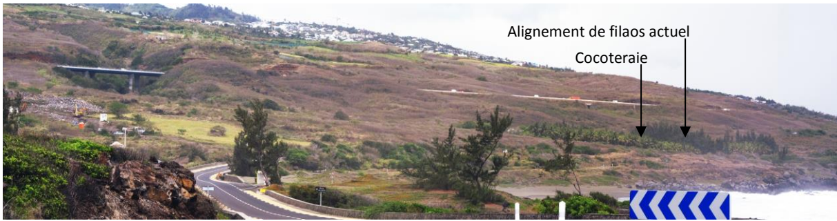
Vue depuis la RN1a – état initial.
