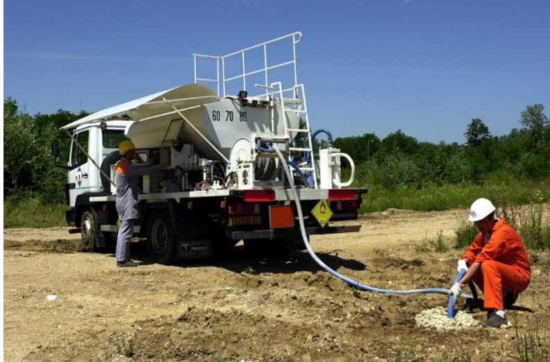
Planche 6 : Mise en œuvre d'explosif par une UMFE
