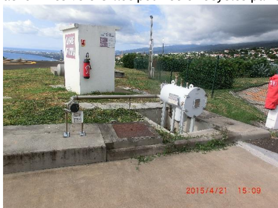
Figure 5. Cuves à hydrocarbures et pompe
