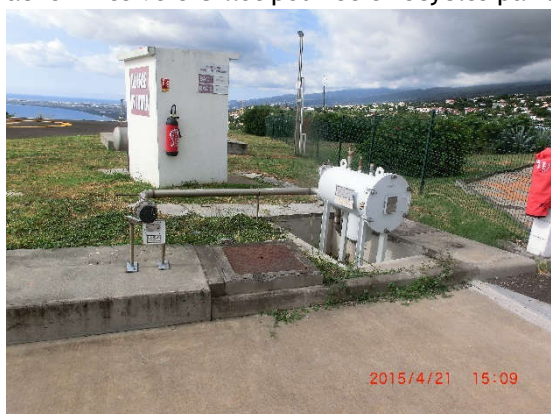
Figure 5. Cuves à hydrocarbures et pompe
