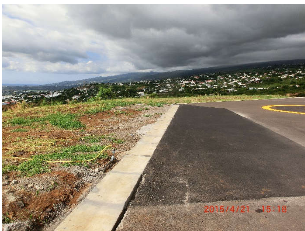
Figure 6. Vue du FATO et des caniveaux / Vue générale FATO et aires de stationnement
