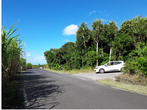
Photo de la sortie du chemin béton. A mettre au pied du vacoa (lisible depuis la RD3 et le chemin)
