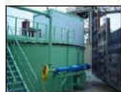
Pompe à rotor excentré
