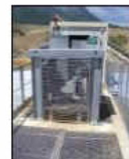
Mécanisme d'entraînement et de relevage du racleur
