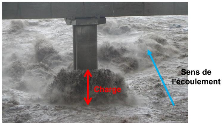
Fig. 9. Représentation de la charge sur une pile de pont
