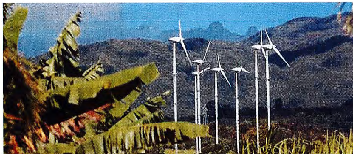
Vue partielle depuis le voisinage immédiat
