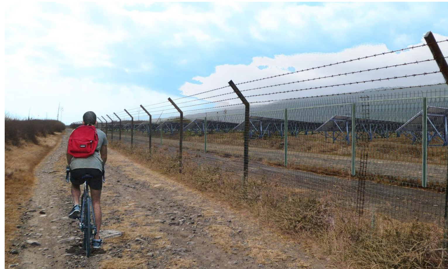
Fig. 73. Perceptions du site 3 en exploitation, depuis la piste d'exploitation
