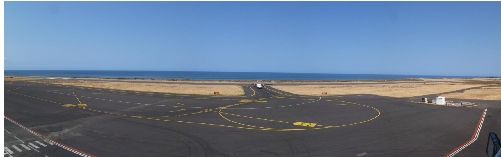
Fig. 65. Perception depuis la tour de contrôle sur le site 3 existant
