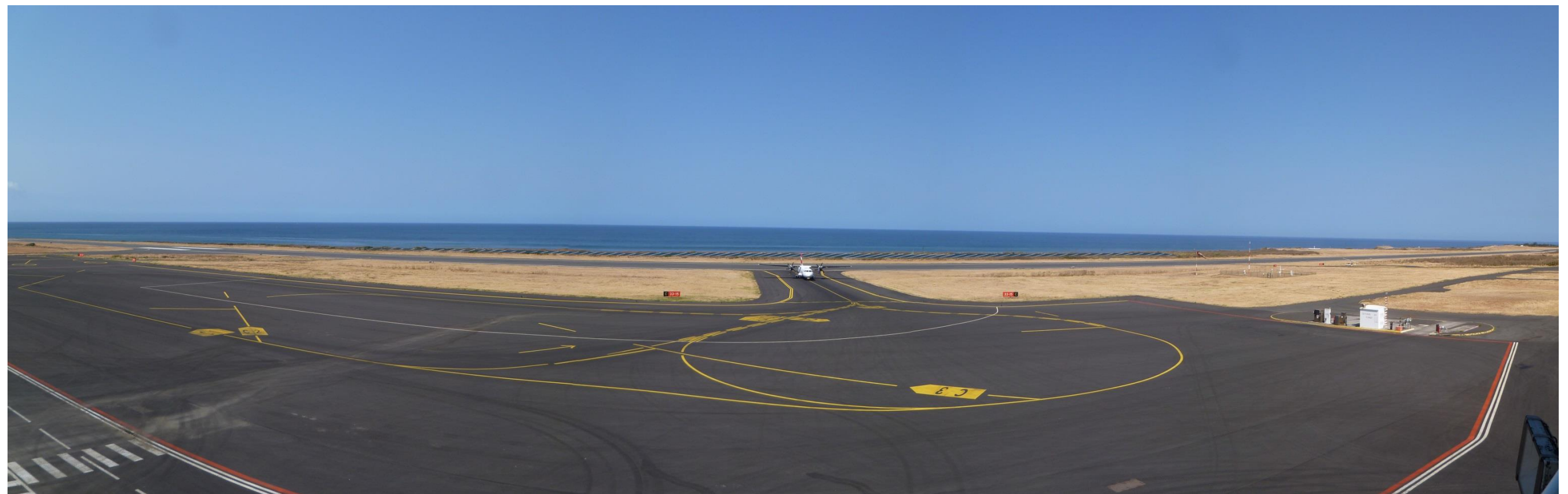
Fig. 66. Perception depuis la tour de contrôle sur le site 3 en exploitation
