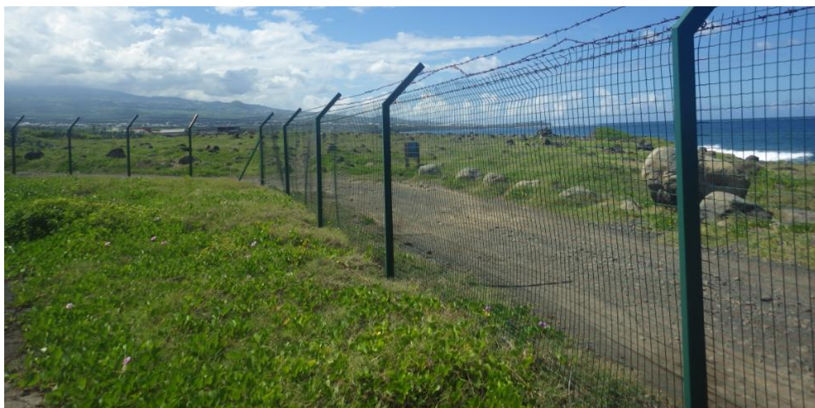
Fig. 60. Vue sur le sentier littoral depuis l'enceinte de l'aéroport.
