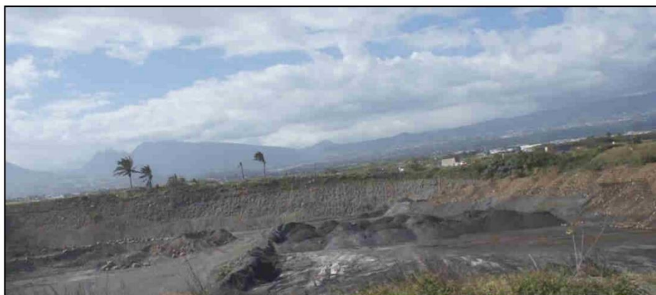
Planche 12 : Remise en état en cours de la carrière de PREFABLOC AGREGATS à Saint-Pierre avec les SPC d'ALBIOMA
