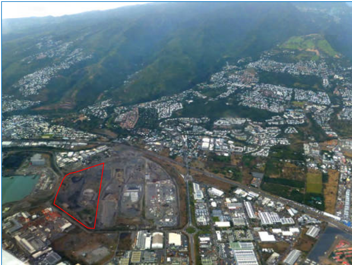
Figure 1 : Vue aérienne sur la zone d'étude élargie et zone d'étude réduite (en rouge) (Photo : © N. PARANTHOËN, 03/08/2015)
