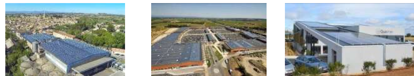
Figure 7 : Centrales photovoltaïques en toiture
