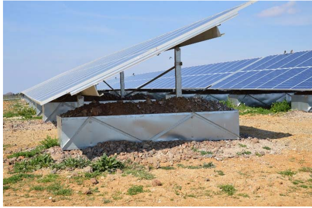
Figure 3 : Design standard avec longrines ou caisse de lestage
