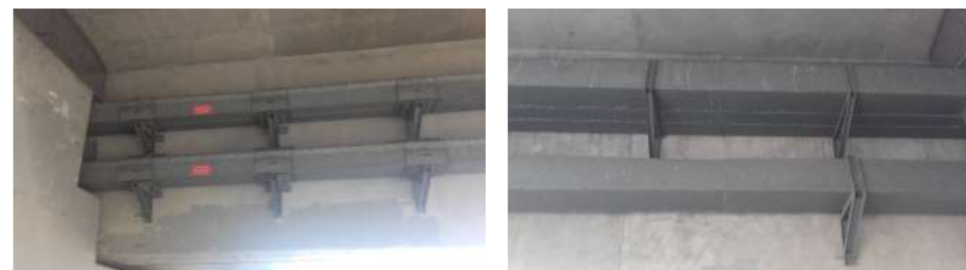
Figure 71 : Passage de câbles de la Rivière des Galets (Source : TOTAL QUADRAN)
