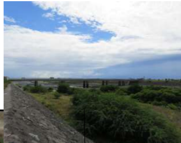
Endiguement et canal d'écoulement de La Rivière des Galets
