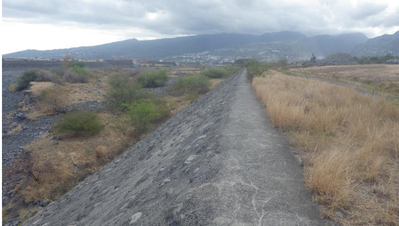
Photo 4- Ouvrage d'endiguement aval RG au droit du site
