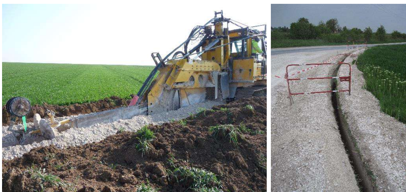
Figure 22 : Exemples de tranchées réalisées (Source : TOTAL QUADRAN)
