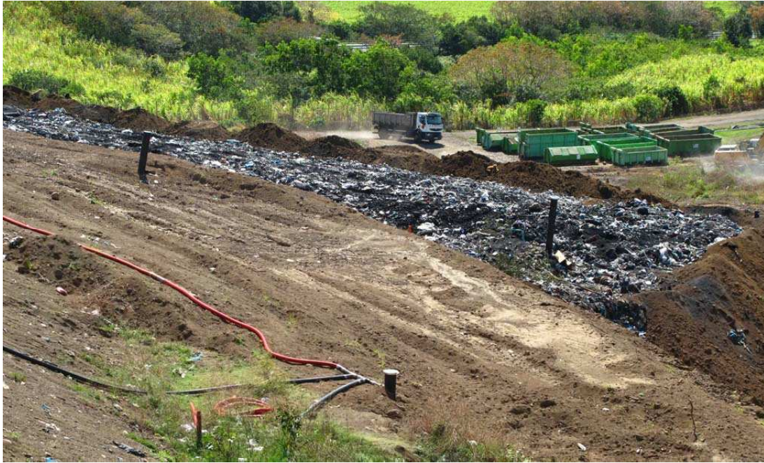
Photo 2 : ISDND de Sainte Suzanne ; zone en exploitation Les puits de captage du biogaz à l'avancement sont visibles (photo prise le 11 septembre 2014)
