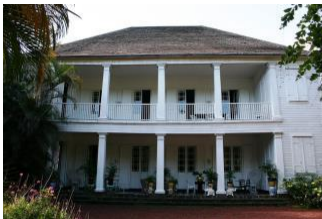
Figure 76 : Photo de la Maison Bel-Air
