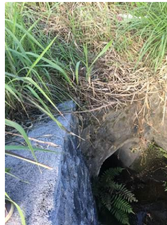
[C] Exutoire du Ø800 de la clinique Durieux au droit du fossé bétonné 2m x 1m
