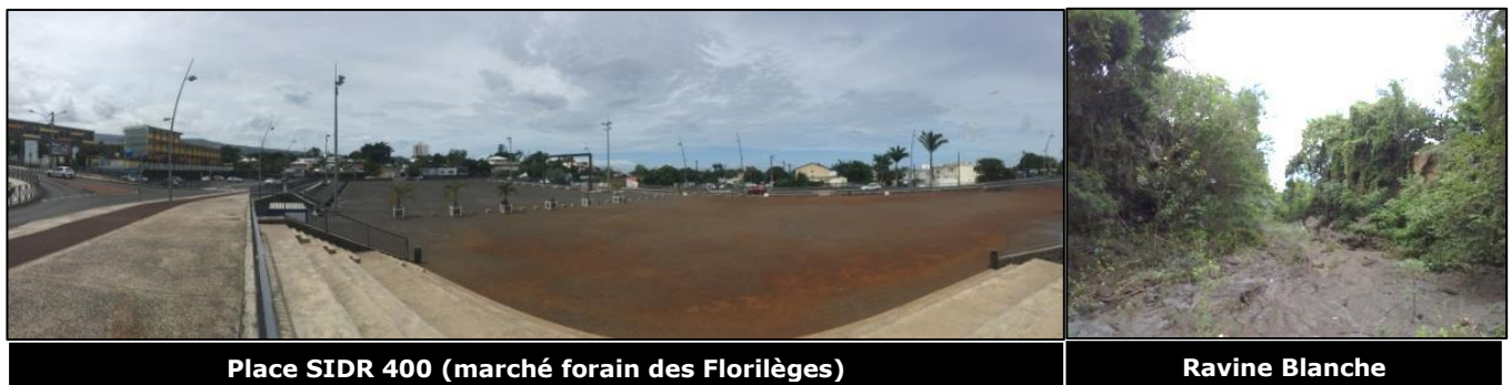
Figure 2 : Présentation de la section 1, en état initial
