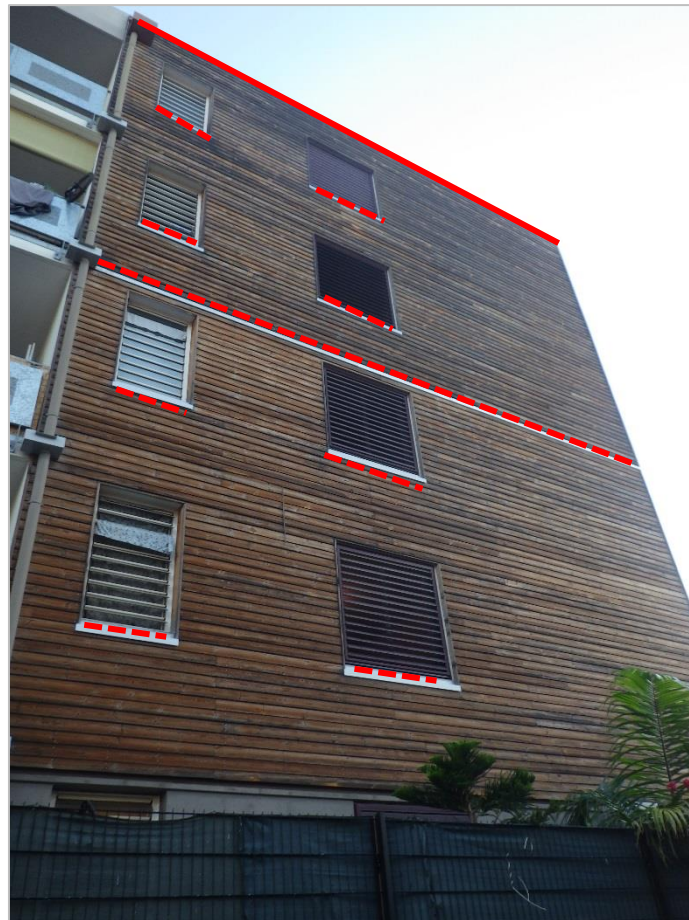
Figure 3. Façade principale occupée par le Petit Molosse : en rouge les tôles servant d'accès au bardage. Accès principal sur le solin en trait plein situé tout en haut de la façade.
