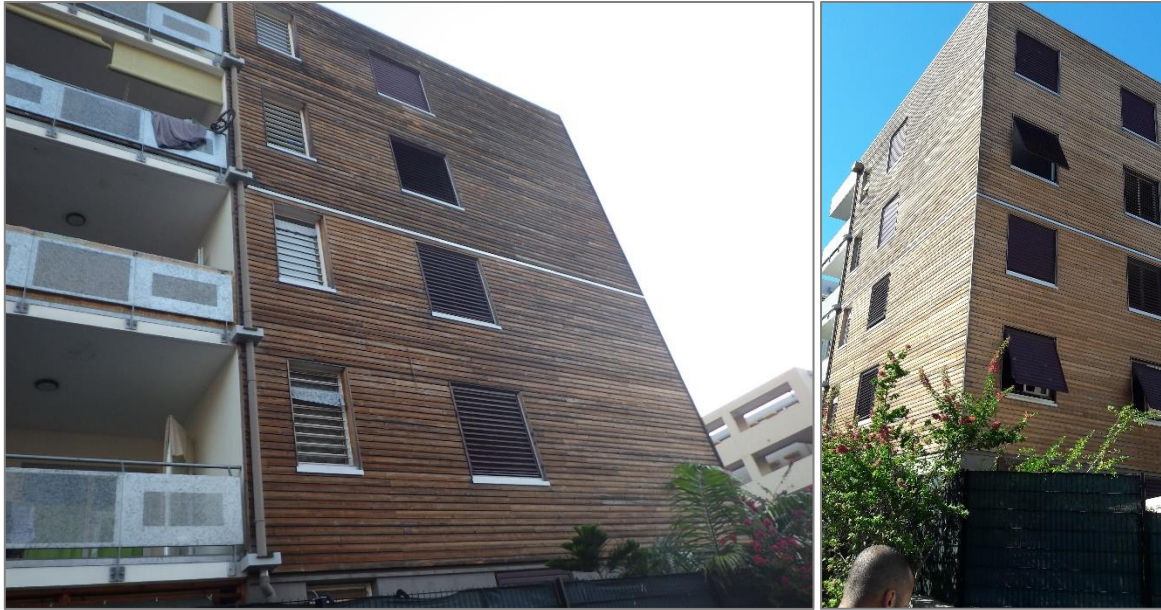
Figure 2. Gîte 1 (façade photo de gauche) et gîte 2 (façade attenante, à droite)
