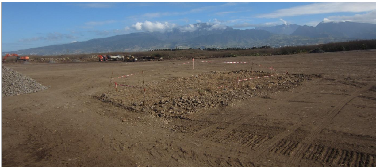
Figure 11. Délaissé 3 fraîchement terrassé et zone non terrassée mise en défend
