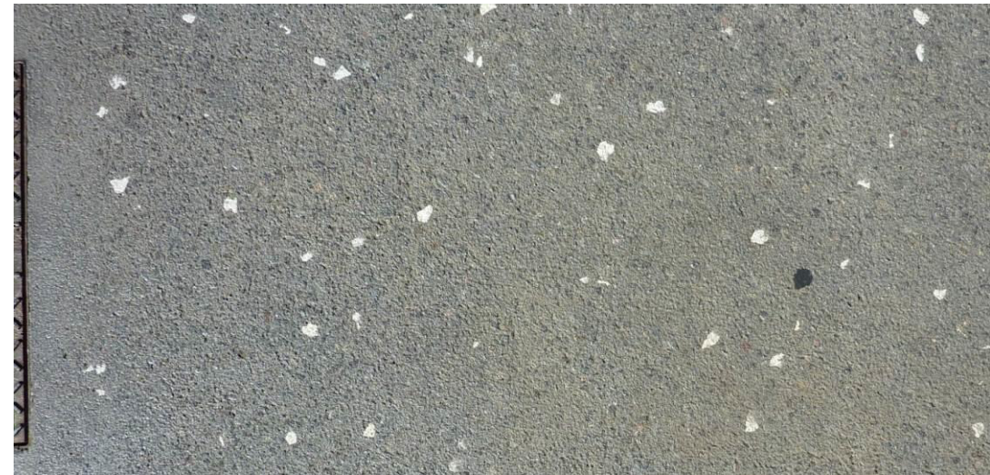
Revêtement au droit des stations
