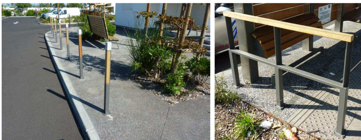
Figure 18 : Potelets (à gauche) et barrières (à droite)
