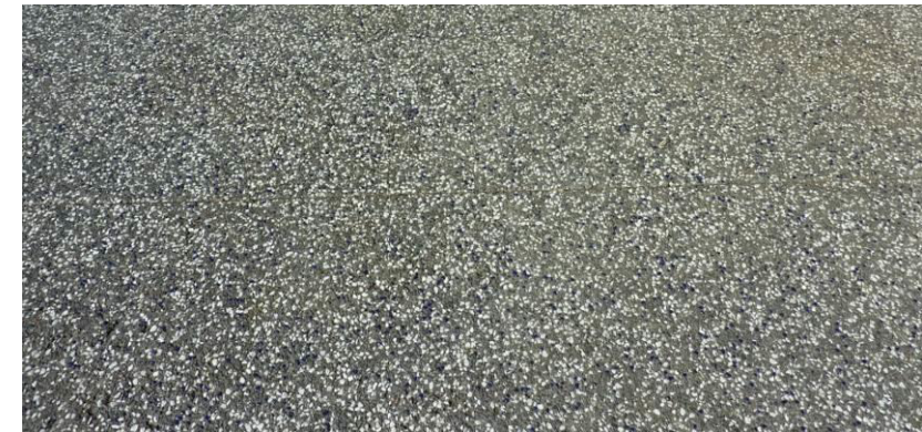
Revêtement présent sur les quais de stations
