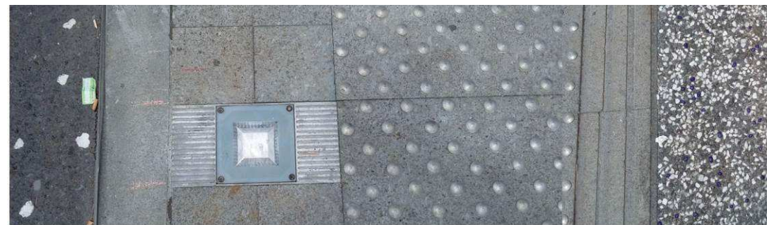
Revêtement spécial station béton érodé noir et blanc | Bordure de quai en basalte | Pavé de basalte avec éclairage | Dalle podotactile | Rail de guidage | Béton d'incrustation
