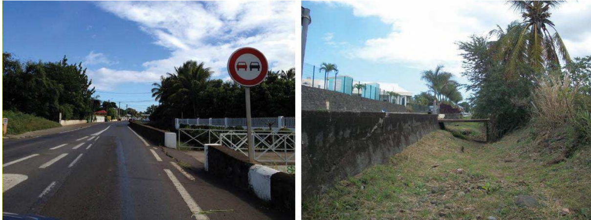
Figure 19 : Ravine Deschenez longeant la RD11 (à droite « l'ouvrage » existant qui sera démolé)
