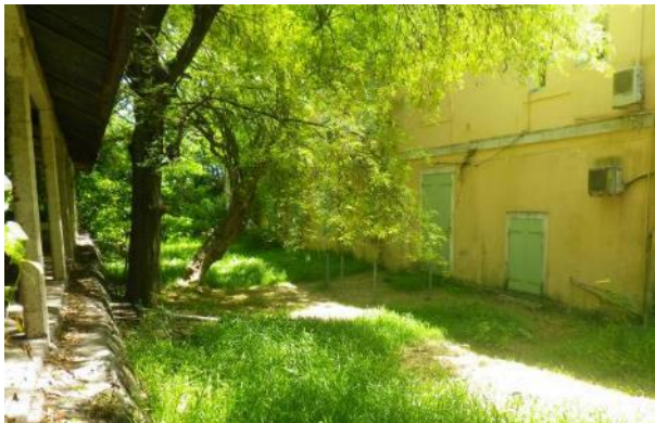
Arrière du bâtiment Coste
