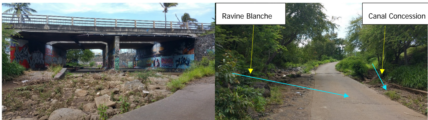
Figure 8 : Pont RN3 de la ravine Blanche à gauche et vue au droit de la confluence à droite
