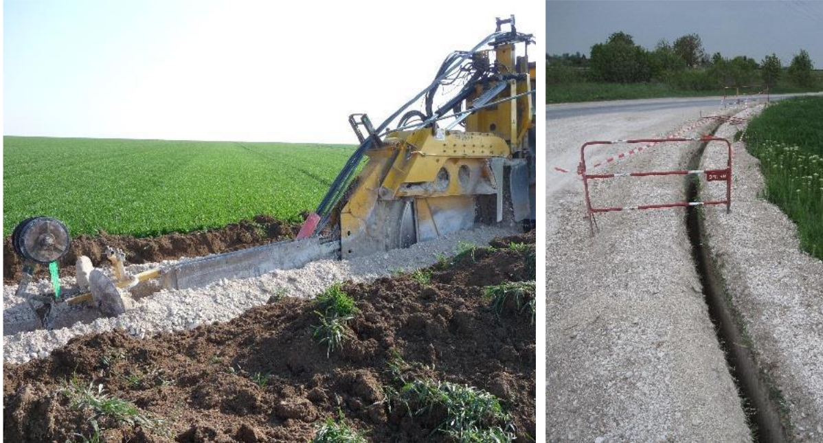
Figure 10 : Exemples de tranchées réalisées (Source : TotalEnergies)
