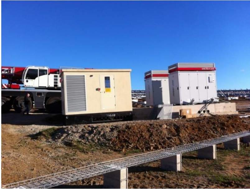
Figure 5 : Exemple de mise en place de locaux techniques (Source : TotalEnergies)
