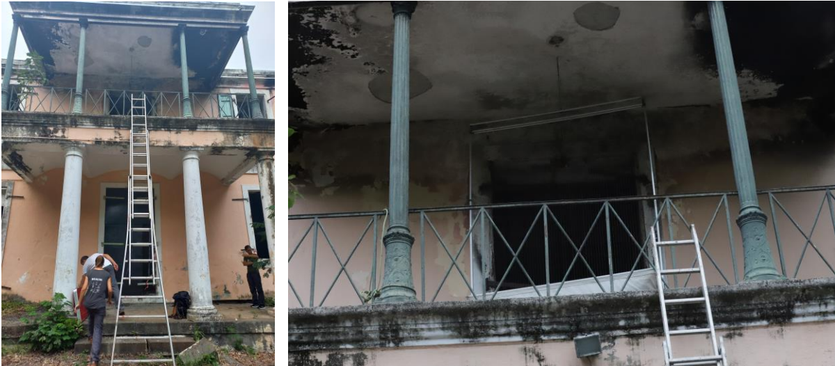
FIGURE 2 | MISE EN PLACE DU PIÈGE HARPE.
