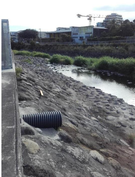
Figure 21 : Exutoire du réseau d'eaux pluviales dans la Rivière St Denis
