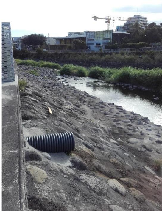
Figure 9 : Exutoire du réseau d’eaux pluviales dans la Rivière St Denis
