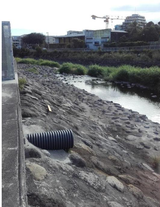
Figure 22 : Exutoire du réseau d'eaux pluviales dans la Rivière St Denis
