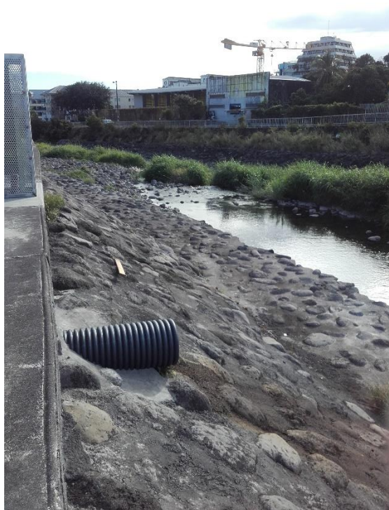
Figure 10 : Exutoire du réseau d'eaux pluviales dans la Rivière St Denis
