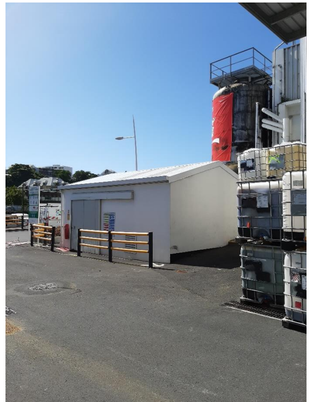
Local décantation eaux de process avant rejet vers la STEP
