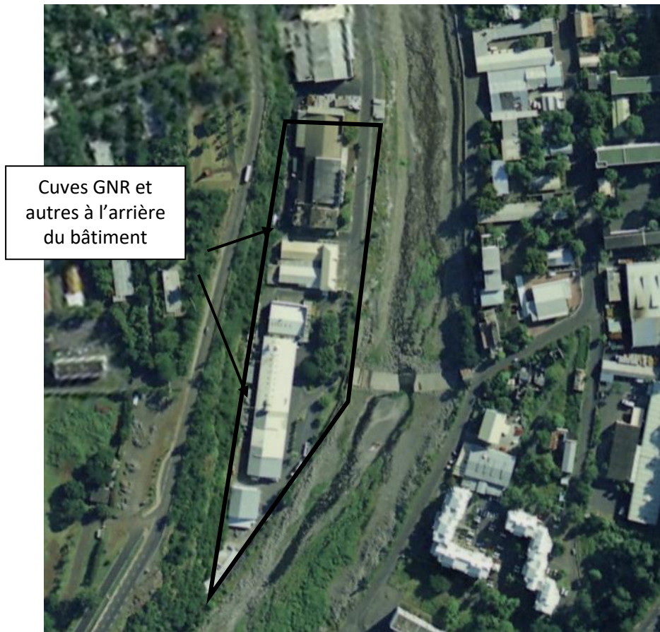
1989 - Observations de cuves à l'arrière du bâtiment dans une zone qui ne semble pas revêtue
