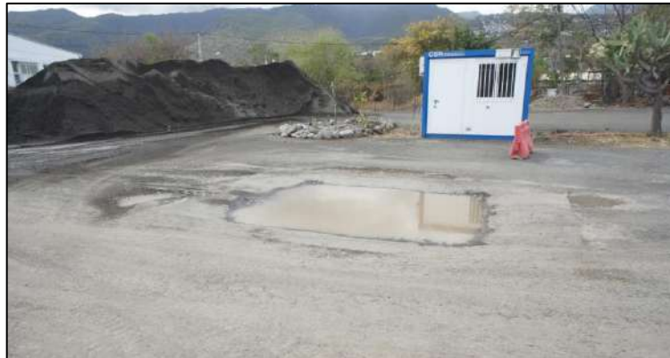
Planche 108 : Fosse de lavage des roues des camions (source : EMC2 Environnement)
