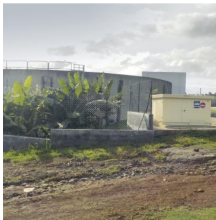
Usine de traitement du forage les Cafés
