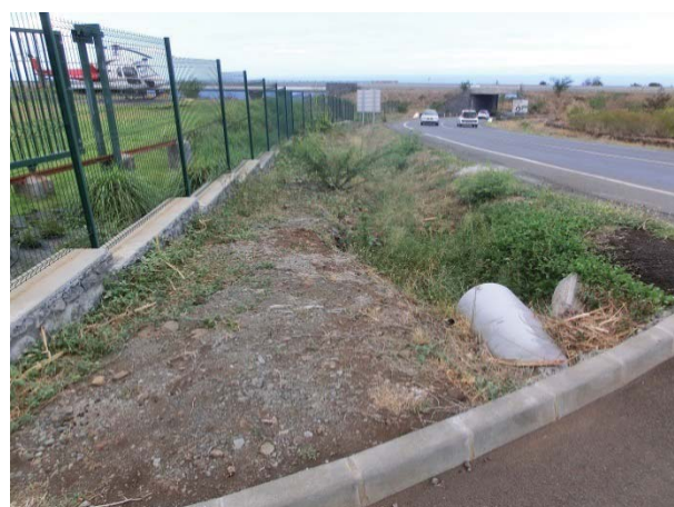
Figure 16 : Fossé collecteurs des eaux pluviales.
