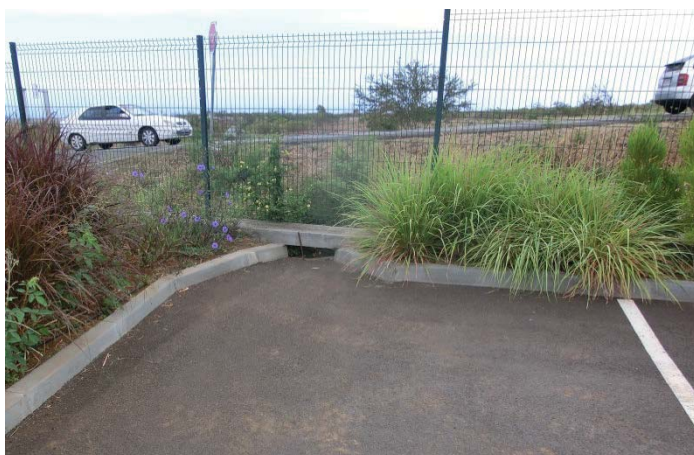
Figure 17 : Photo de l'exutoire des eaux pluviales.
