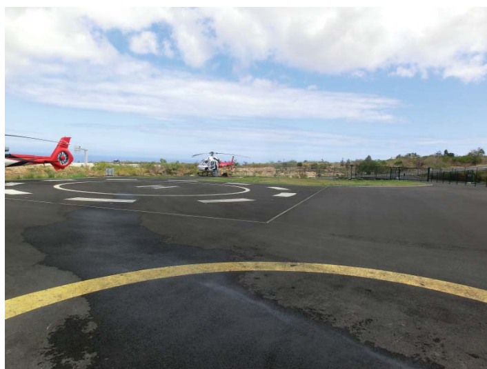
Figure 12 : Vue générale FATO et aires de stationnement.
