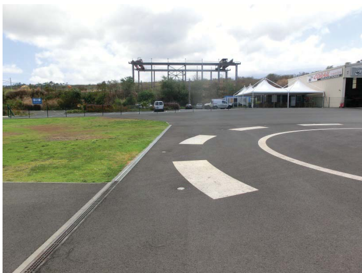
Figure 11: Vue du FATO et des bureaux et hangar, au second plan.
