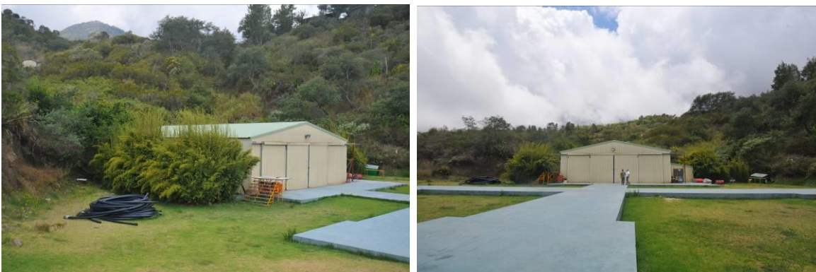
Photographie 8 : Le hangar de l'hélistation de Mafate à la Nouvelle. BIOTOPE, 2013.
