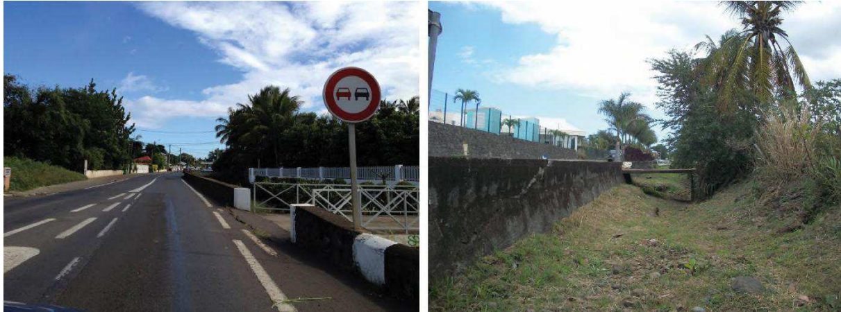
Figure 17 : Ravine Deschenez longeant la RD11 (à droite « l'ouvrage » existant qui sera démolé)
