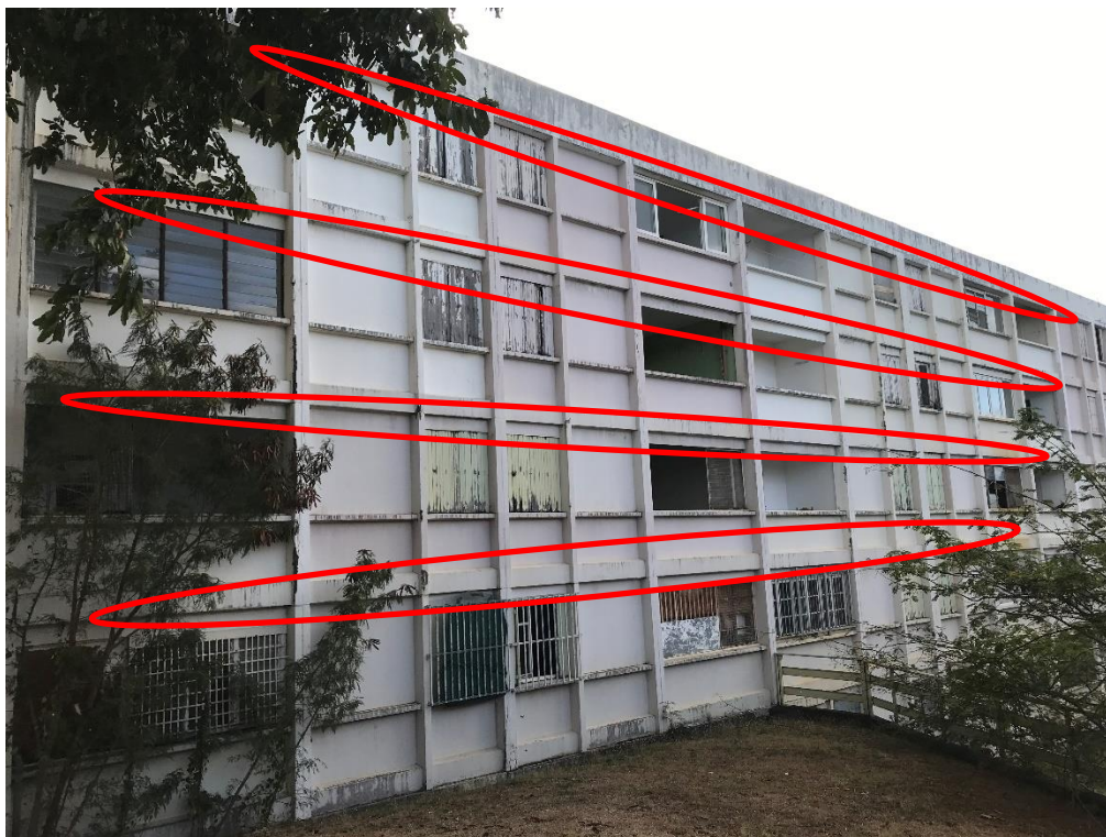
Figure 5 : Localisation des secteurs avec présence de joints occupés par le Petit molosse – Bâtiment Y
